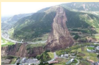
②土砂災害の状況 (熊本県南阿蘇村)
