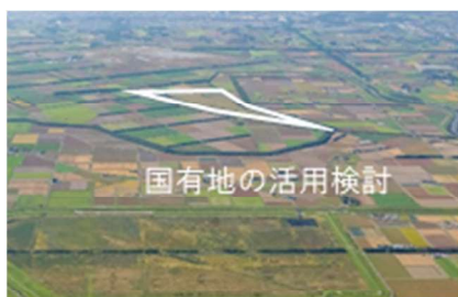
国有地を活用した貯留施設
