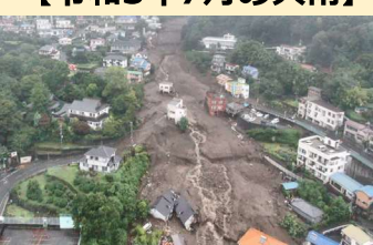
⑪土砂災害の状況 (静岡県熱海市)
