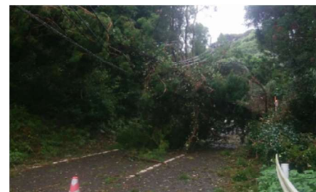
倒木による断線及び道路閉塞
