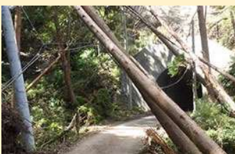
⑦電柱・倒木倒壊の状況 (千葉県鴨川市)
