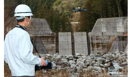
ドローンを活用した砂防施設点検
